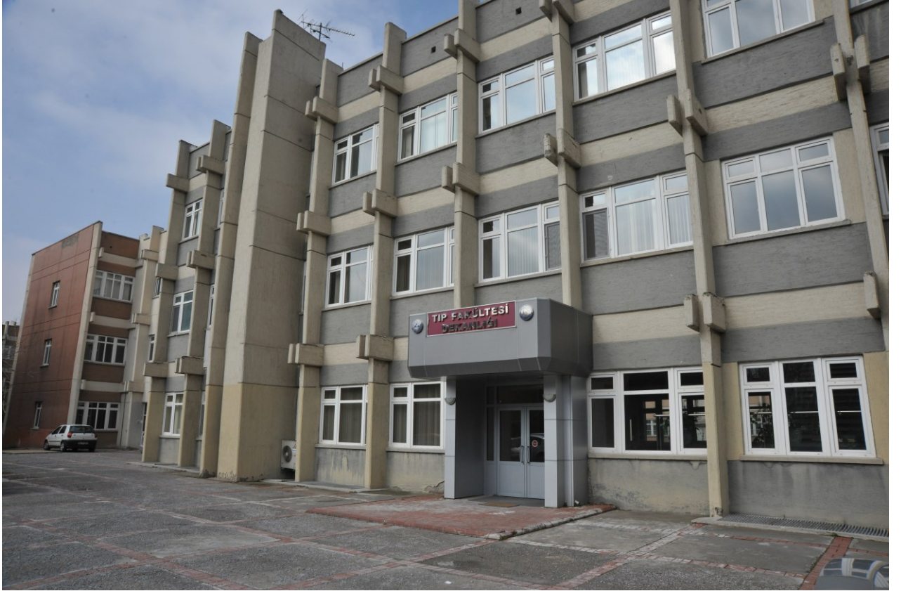
Tıp Fakültesi İdari Binası
