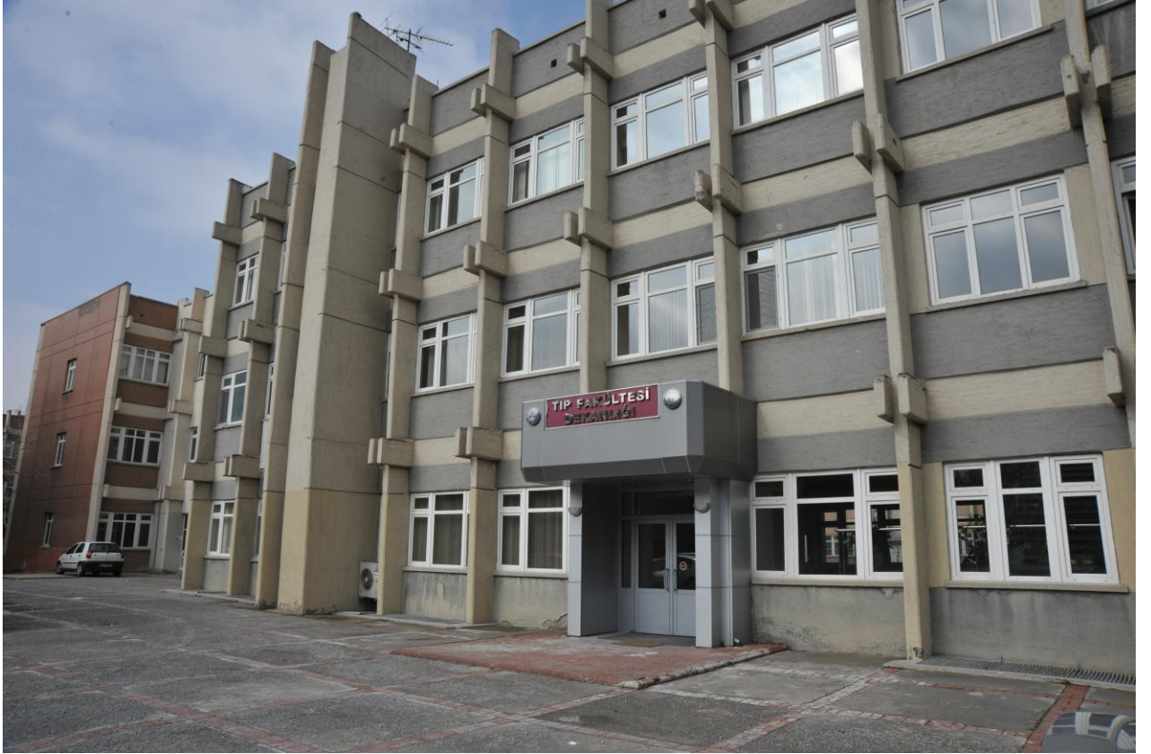
Tıp Fakültesi İdari Binası
