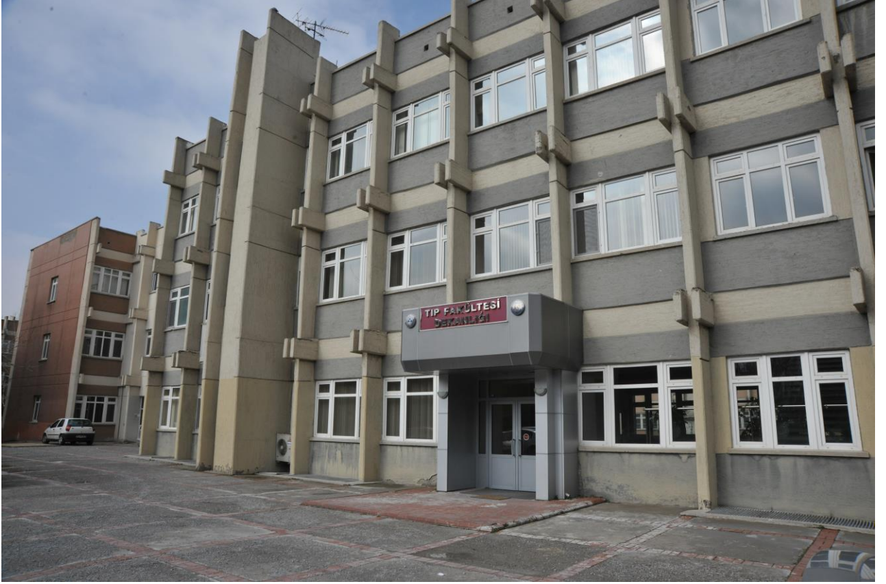
Tıp Fakültesi İdari Binası
