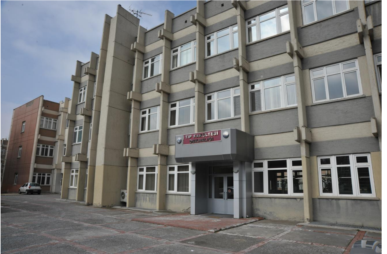
Tıp Fakültesi İdari Binası
