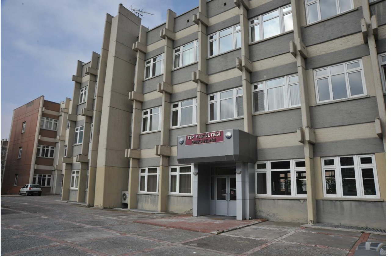
Tıp Fakültesi İdari Binası
