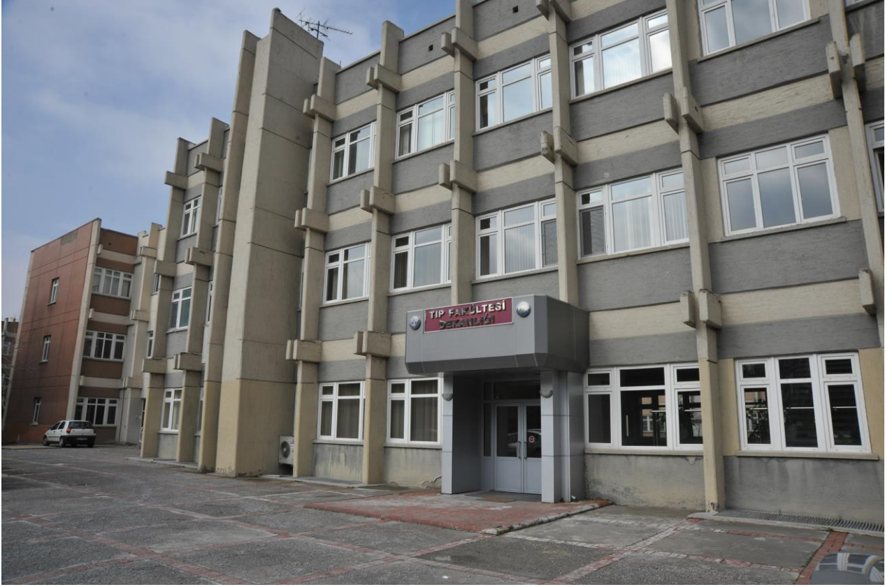
Tıp Fakültesi İdari Binası
